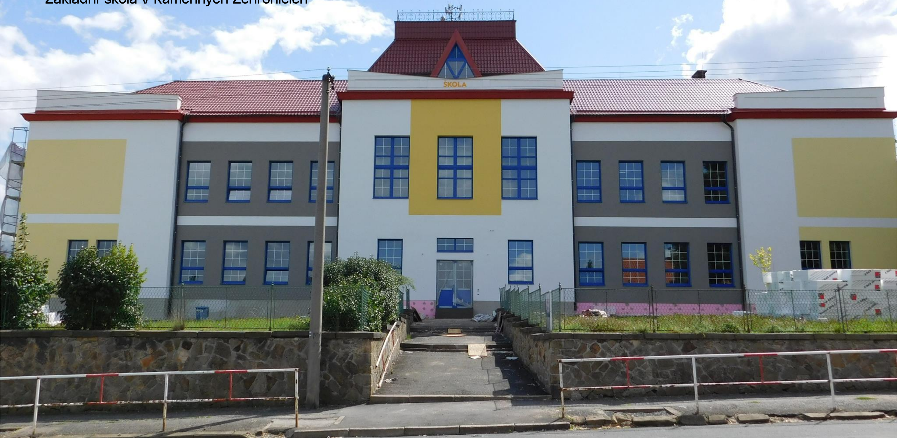
Základní škola v Kamenných Žehronicích
